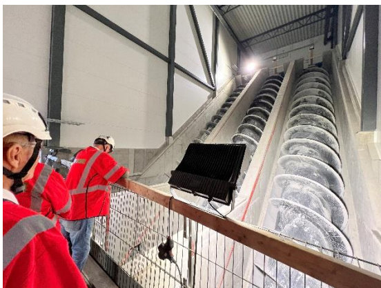
Et imponerende syn: Europas største arkimedesskruer!
