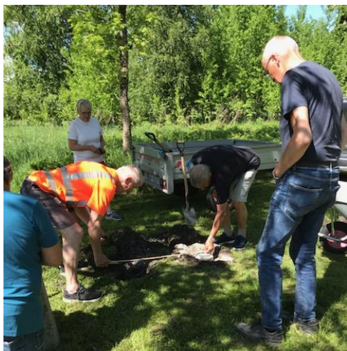
Finmåling for å få riktig senteravstand mellom hullene – før vi graver for dypt!
