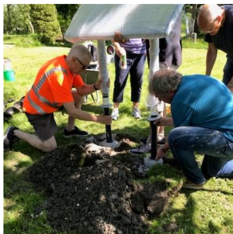
Betongsoklene på plass – og beina passet!
